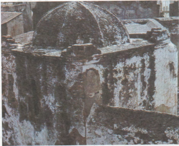
البطارية الخامسة برج المراقبة
